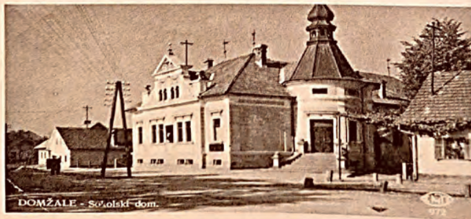
Sokolski dom je stal na mestu sedanje Elektrotehne in je bil po zunanosti in notranji ureditvi med najlepšimi stavbami daleč naokoli. Slovesno je bil odprt 6. avgusta 1911, načrt je izdelal Franc Ravnikar
